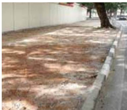
Figura 05 – Nivelamento e compactação do terreno
