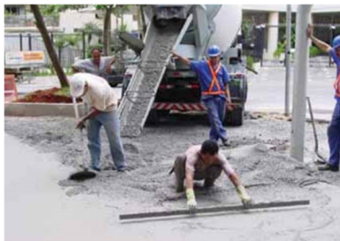
Figura 07 – Recebimento e espalhamento do concreto.
