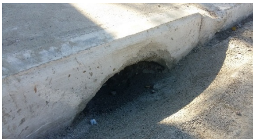
Figura 03 – Detalhe rebaixo na Boca de Lobo
