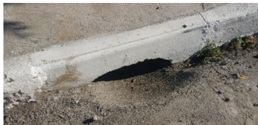
Figura 03 – Detalhe rebaixo na Boca de Lobo
