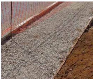
Figura 06 – Espalhamento da camada de Brita
